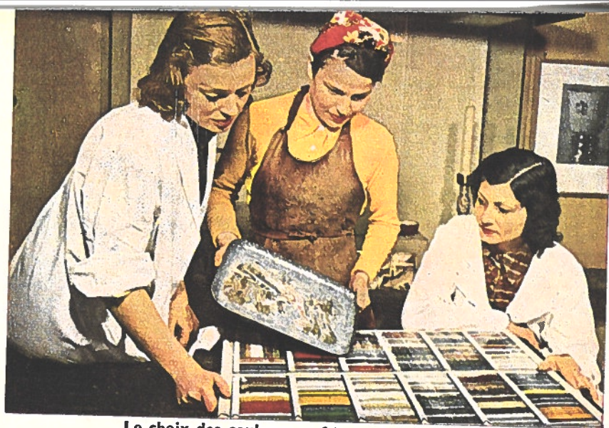
Le choix des couleurs se fait sur de petits échantillons déjà passés au four, car le verre pilé change de couleur au four
