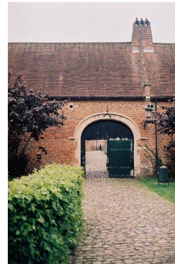
Entrée depuis la Volmolenlaan
