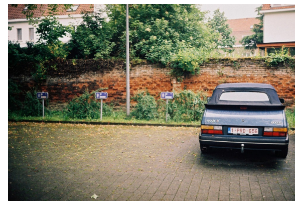
Parking et mur d'enceinte du béguinage
